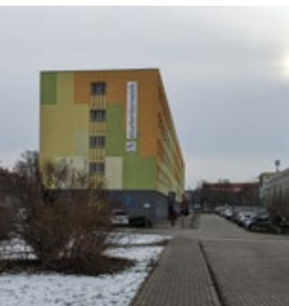
StudWerk Magdeburg Wohnheim Magdeburg
