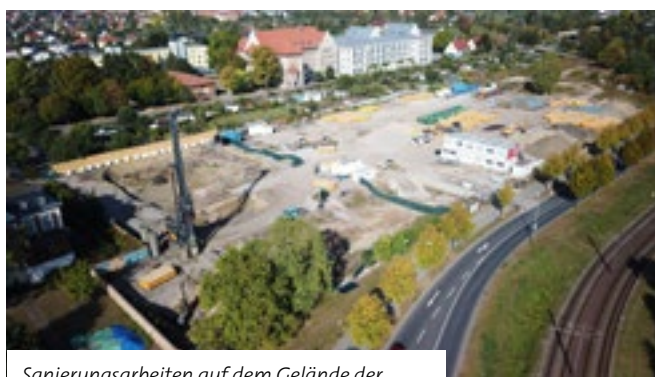
Sanierungsarbeiten auf dem Gelände der ehemaligen Lackfabrik in Magdeburg
