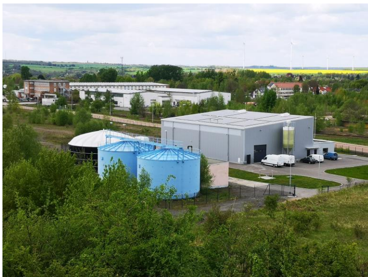
©Landesanstalt für Altlastenfreistellung Neubau der Neutra-Anlage zur Reinigung kontaminierten Sickerwassers am Standort Helbra
