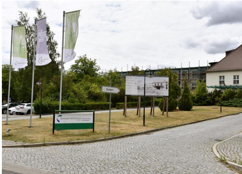
© Altmark-Klinikum gGmbH Krankenhaus Gardelegen
